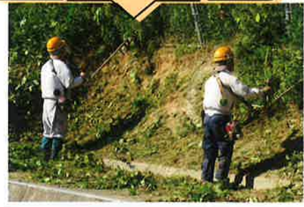
江田島公園除草作業
