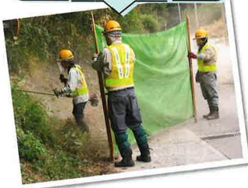
市道1号線除草作業
