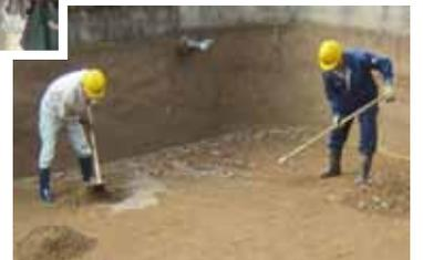
は、江田島市企業局・浅野環境ソリューションからの発注により、市内6カ所の浄水場でメンテナンスの一部である砂ろ過槽(池)の砂表面削り作業を定期的に行っています。
