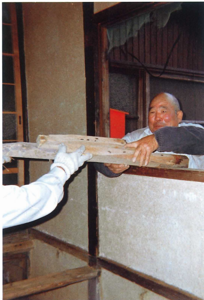
■家屋補修作業
