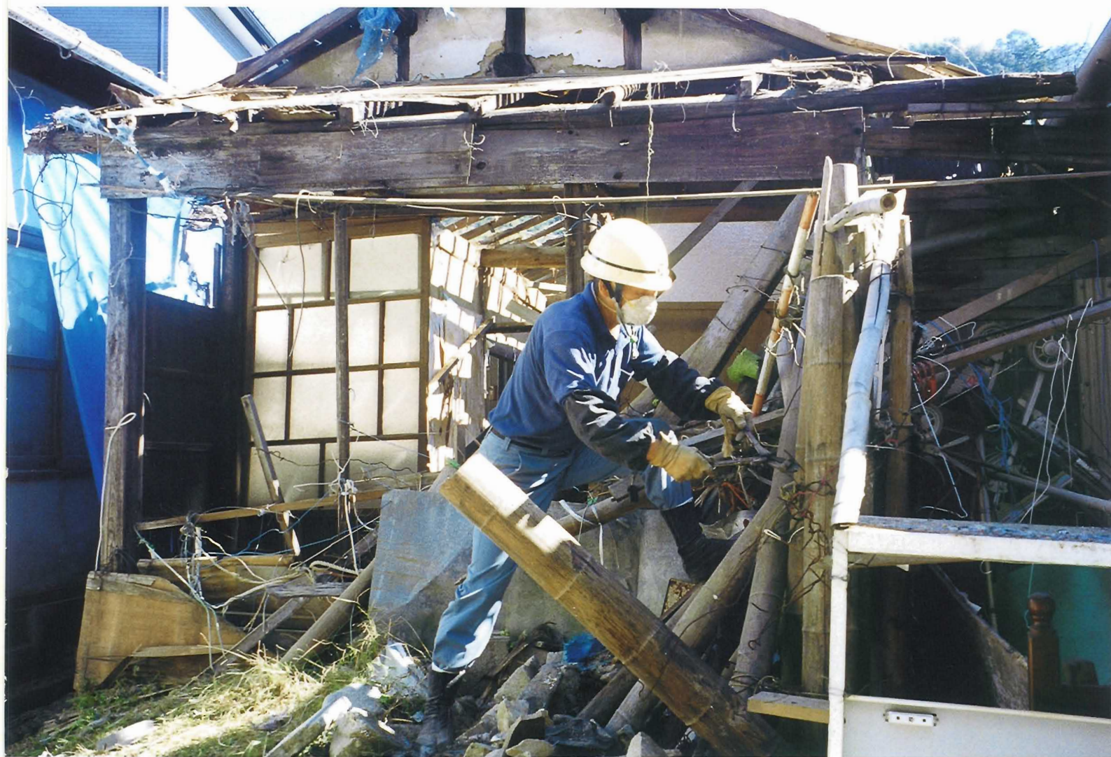
■家屋解体作業
