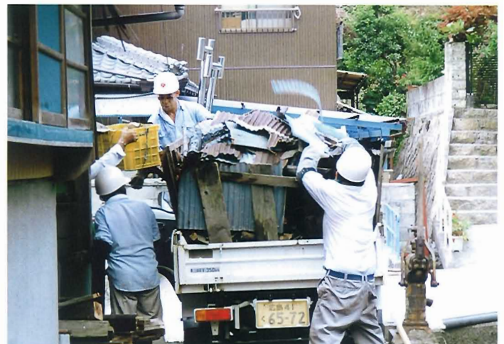
■廃棄物処分作業
