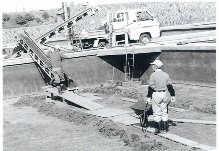
■浄水場砂かき作業
