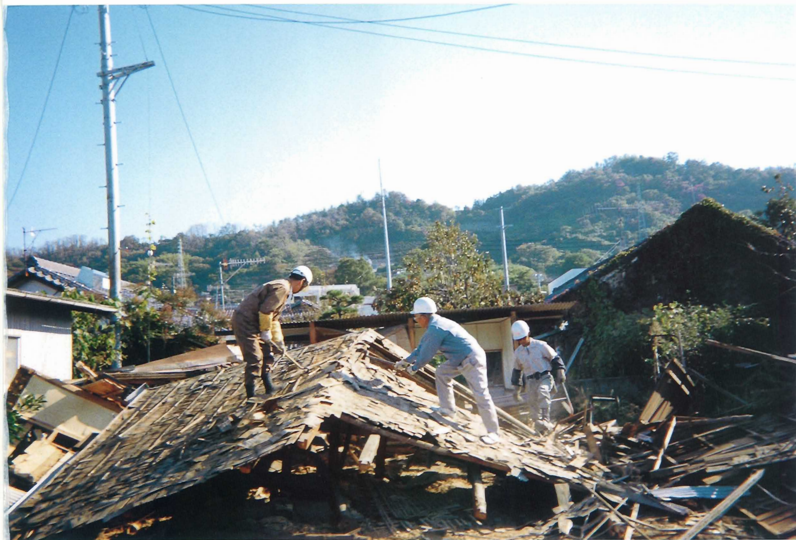
■家屋解体作業
